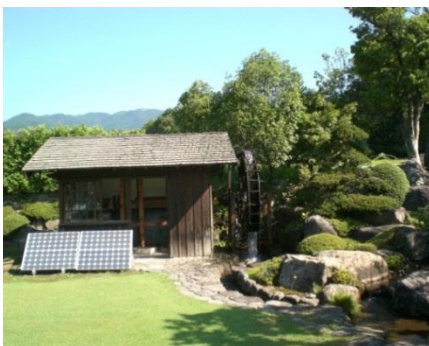
平成8年8月24日から連続稼働
