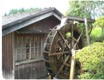
上掛け水車：2200φ (本社事務所)
